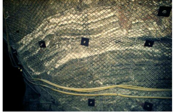
Foto 39: Wenig druckfestes, gegen Nachbruch durch Maschendraht gesichertes Carnallit auf der 750-m-Sohle von Asse II
