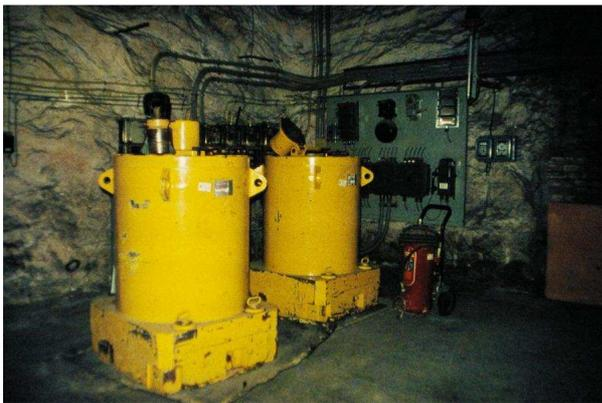
**Foto 9: Typ B2-Abschirmbehälter (à ca. 9 t) am Schachteingang der 490-m-Sohle ca. ½ Jahr nach der letzten Einlagerung von MAW-Fässern im Frühjahr 1977**
