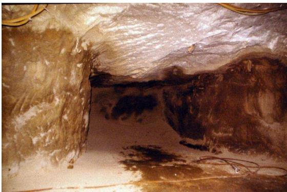
Foto 46: Kammerverschluss einer mit radioaktiven (r.a.) Abfallfässern verfüllten Endlagerkammer auf der 750-m-Sohle von Asse II
