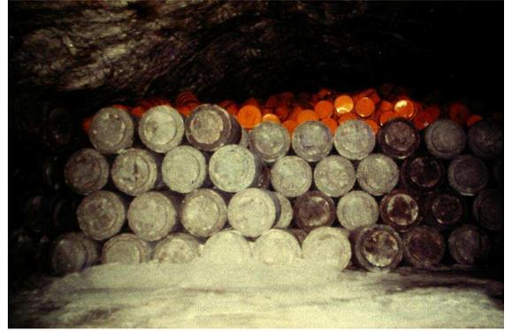
Foto 45: Einlagerungskammer mit orangen 200 I-LAW-Rollreifenässern, davor VBA für LAW/MAW auf der 750-m-Sohle von Asse II
