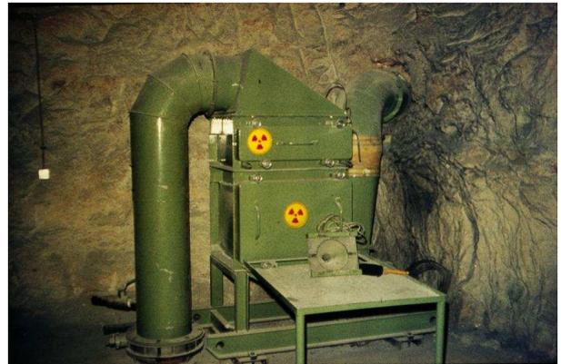
**Foto 12: Abluftanlage auf der 490-m-Sohle zum Absaugen radioaktiver Luftpartikel aus der MAW-Lagerkammer 8a, zur Abluftfilterung und Einspeisung in die Grubenbewetterung von Asse II**
