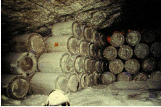
Foto 44: Demonstrationskammer mit „Verlorenen Betonabschirmungen“ (VBA) für LAW/MAW auf der 750-m-Sohle.
