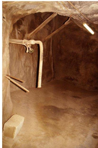
Foto 47: Entnahmestutzen in einem Kammerverschluss einer mit r.a. Abfallfässern befüllten Kammer auf der 750-m-Sohle
